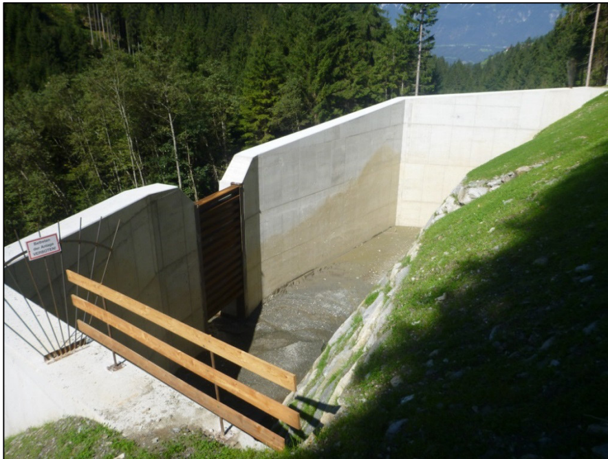
Abbildung 3: Im September 2016 konnten die Sicherungsmaßnahmen fertiggestellt werden.
