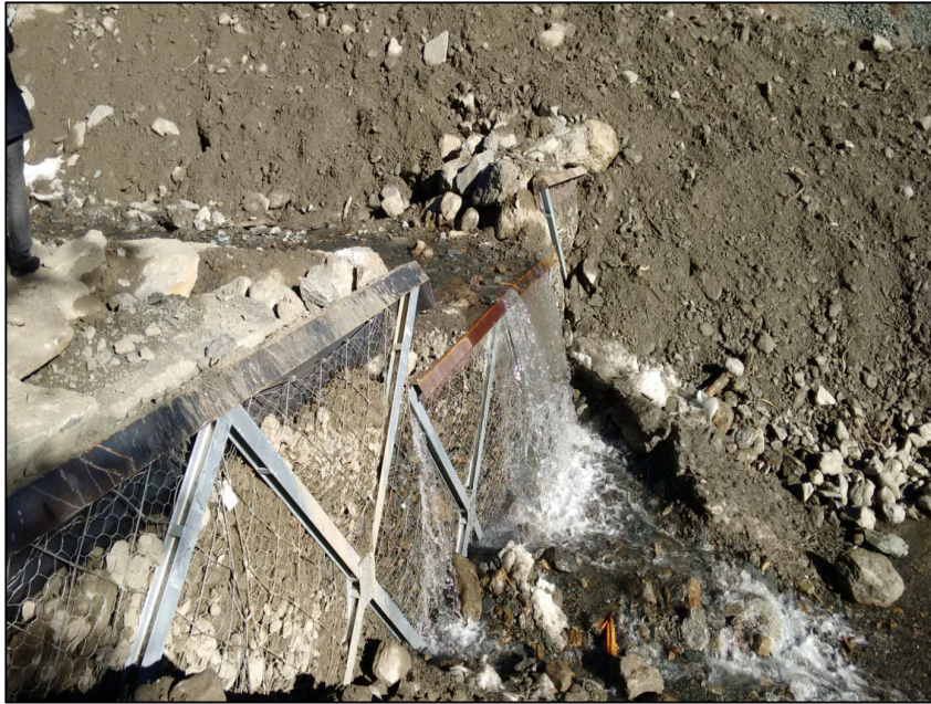
Abb. 5: Kantenschutz mit unverzinktem Blech – modulare Bauweise
