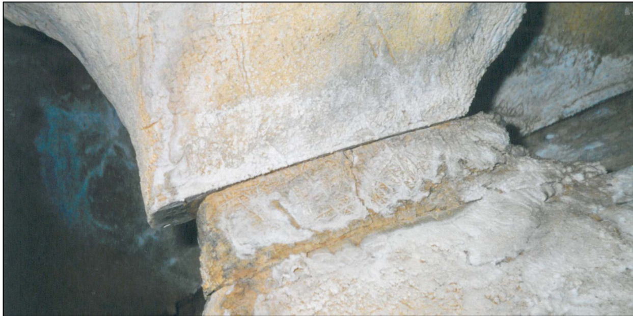
Foto: „Pfeilerbruch“ im Altherrenlabyrinth.
