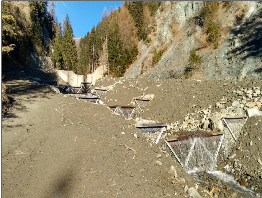
Abb. 4: Vermeidung von Sohleintiefung
