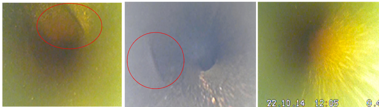
Abb. 7: Delle (links und Mitte) und starke Quetschung des gesamten Sondenrohres (rechts).
