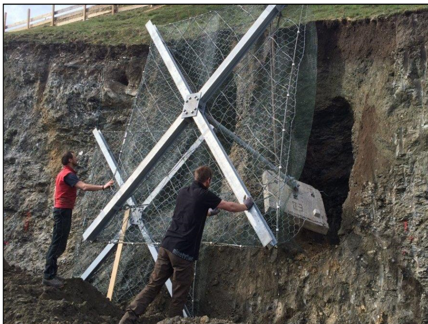
Abb. 1: ERDOX® terra beim Versetzen
