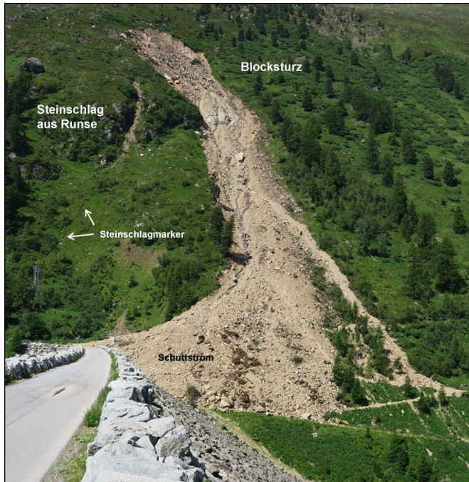
Abb. 1: Übersicht Steinschlag aus Runse und Blocksturzereignis westlich des Dammwiderlagers, Mai 2015. Lage der Erosionsbereiche oberhalb des Gepatsch Dammes
