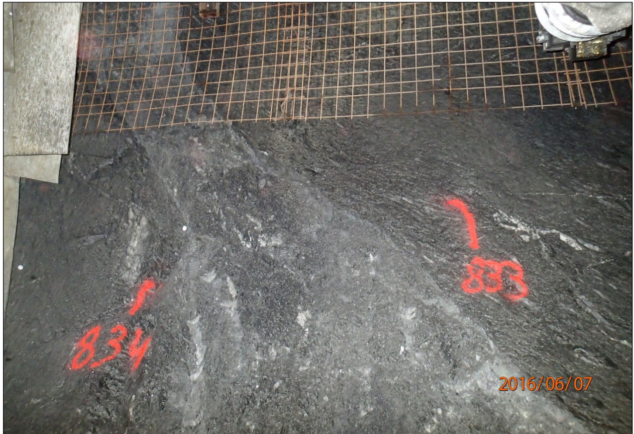
Abb. 8: Foto einer schleifenden, mittelsteil nach W einfallenden Störungs-Kernzone mit variierender Mächtigkeit und Zusammensetzung im Bereich der rechten unteren Tunnellaibung im TBM-Vortrieb bei Projektkilometer 8,38
